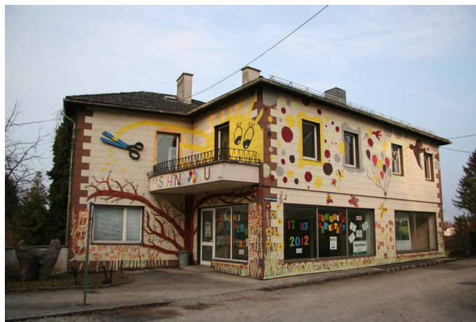
Das Windnerhaus wird heuer noch abgerissen - Der Startschuss einer neuen Ära im Ortszentrum von Hörsching, der gefeiert werden darf.
